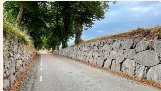
Den ena sidan av stödmuren har åtgärdats. Cirka 30 procent av det ursprungliga stenmaterialet har återanvänts. De tidigare naturstenarna har ersatts med bearbetad sten för bättre stabilitet. Markduk och stenmaterial hindrar rötter från att växa in i stödmuren.
