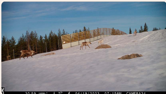
Vandrande ren på faunabron vid Gladaberget. Fotot taget med viltkamera första vintern efter att faunabron byggts klar.
